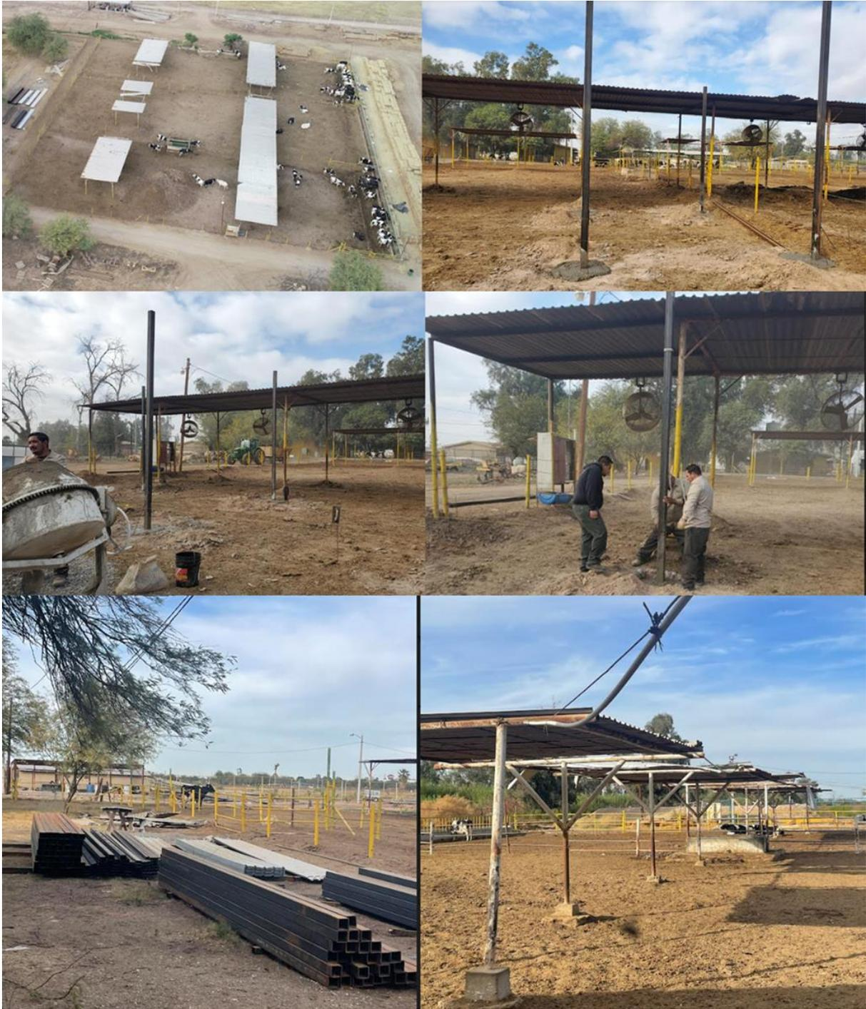
**Figura 9.6.** Proceso de rehabilitación y construcción de nuevas áreas de sombra para ganado en el área de postas.
