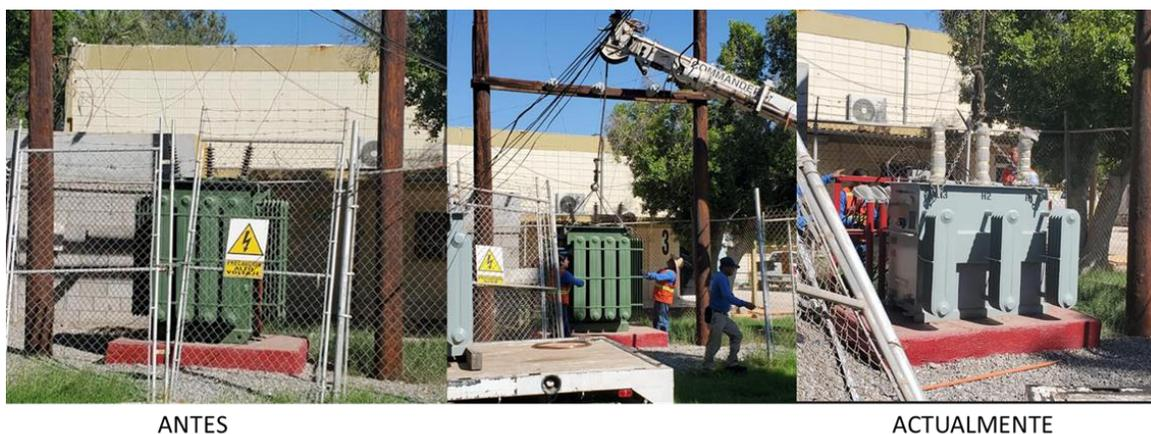
**Figura 9.3.** Instalación de nueva subestación para el ICA
