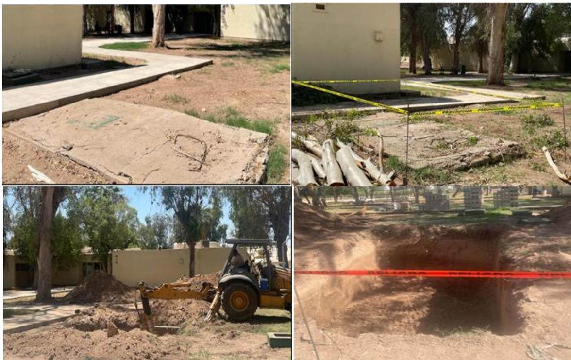
**Figura 9.1.** Construcción de fosa de área de baños centrales
