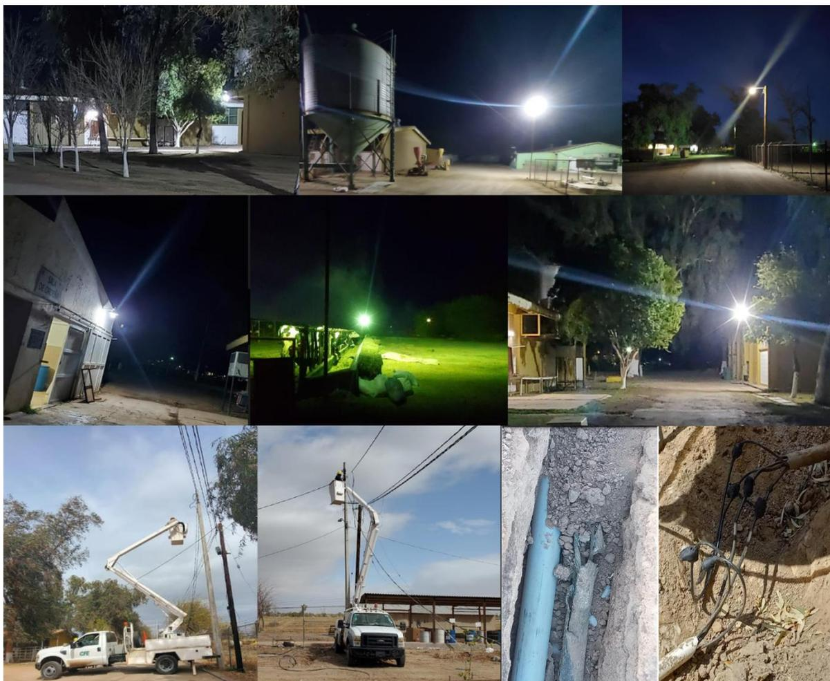
**Figura 9.7.** Instalación de luminarias y sustitución de cableado en diversas áreas de postas 2023.
