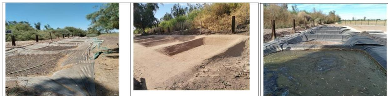
**Figura 9.11.** Establecimiento y mantenimiento del área de secado de lodos de la PTAR
