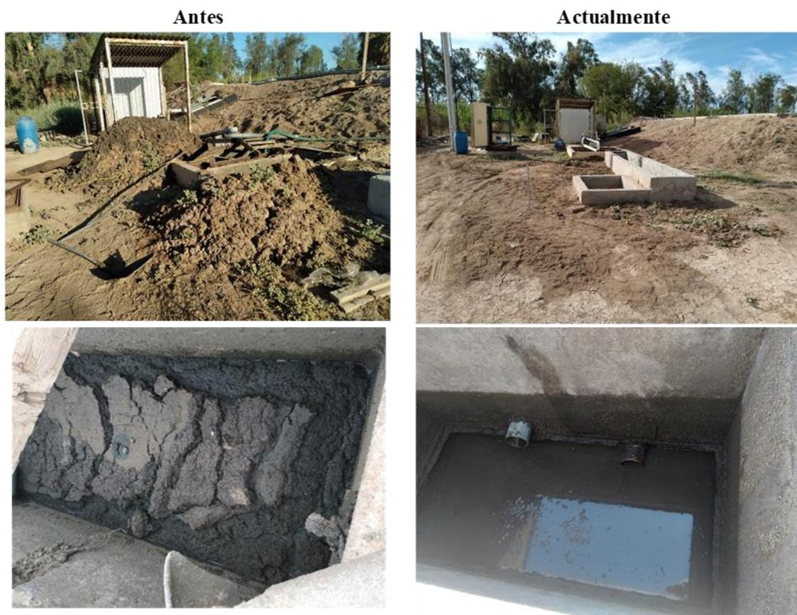
**Figura 9.12.** Mantenimiento del sistema de succión de efluentes
