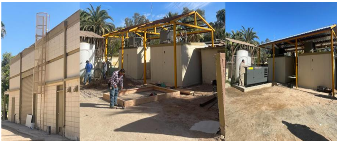
Figura 5.2. Instalación de planta de emergencia. escalera y ramada
