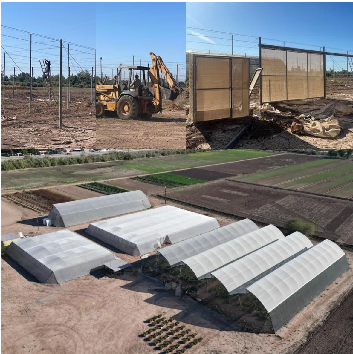
Figura 5.4. Reconstrucción del área de mallas sombra e invernadero del ICA
