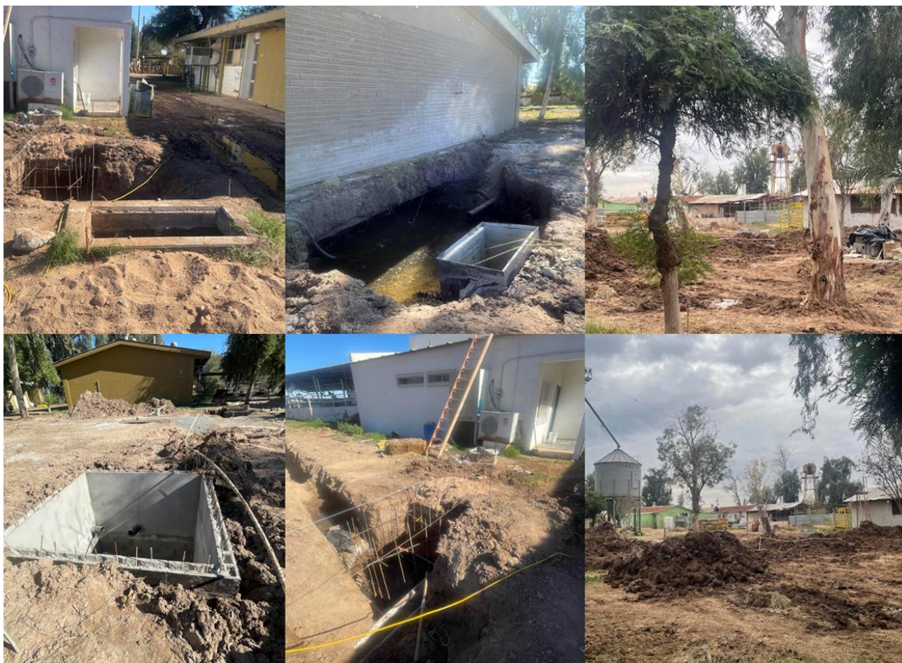
Figura 5.7. Rehabilitación y construcción de red de drenaje del área de postas
