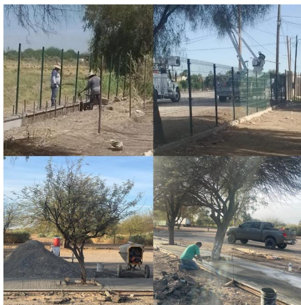
Figura 5.3. Construcción de cerco y banqueta estacionamiento
