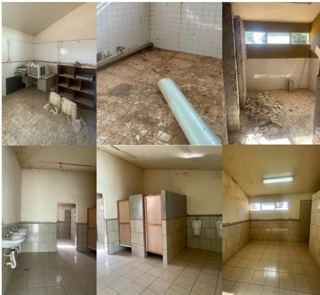
Figura 5.6. Rehabilitación y construcción de sanitarios y regaderas en áreas de postas
