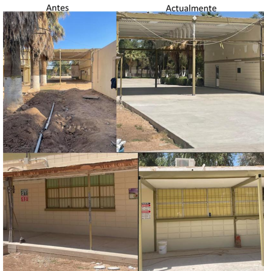
Figura 5.1. Construcción de banquetas y reparación de andadores
